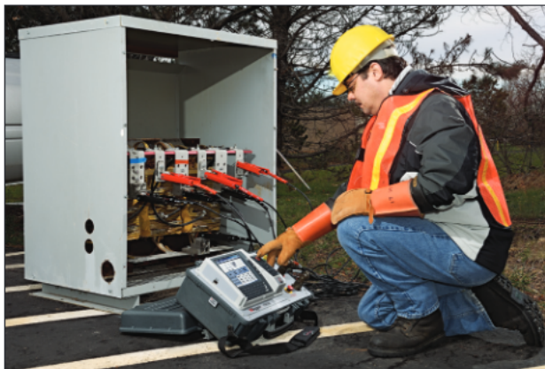
Prueba de un transformador montado en una plataforma con el TTR330
